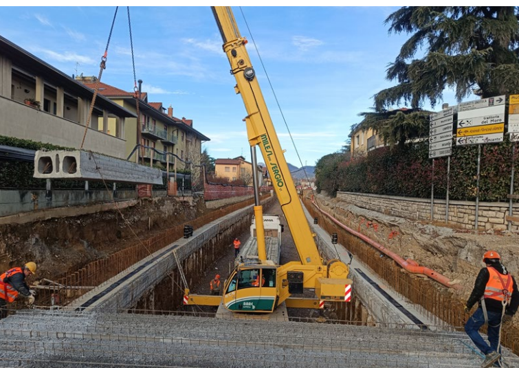
Fasi costruttive della galleria artificiale Maresana: posa delle lastre prefabbricate del solaio tramite autogrù
