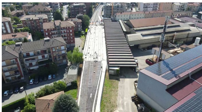
Vista dall'alto dei lavori di banchina e posa delle strutture di servizio presso la nuova fermata Stadio a Bergamo
