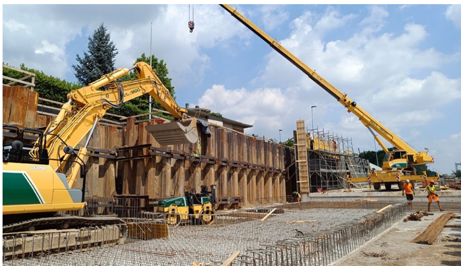
Fasi di costruzione e movimentazione terra con mezzi meccanici per la realizzazione delle opere in calcestruzzo armato del nuovo sottopasso della circonvallazione Fabriciano a Bergamo
