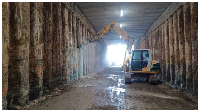
Galleria artificiale Maresana: pulizia dei pali di grande diametro per la formazione dei muri della nuova galleria
