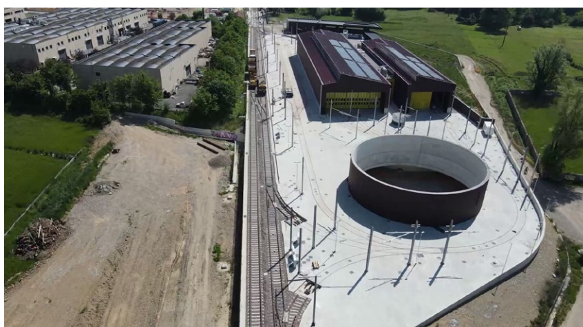
Inquadratura aerea del nuovo deposito di Petosino, centro logistico della linea T2, con i capannoni officina e l'anello ferroviario esterno
