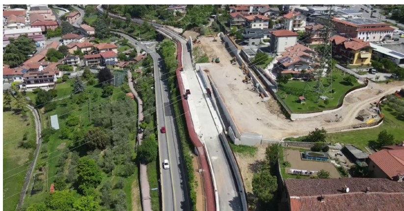
Panoramica aerea dello stato di avanzamento della fermata Almè Mazzi e delle aree attigue destinate al parcheggio scambiatore e alla pista ciclopedonale
