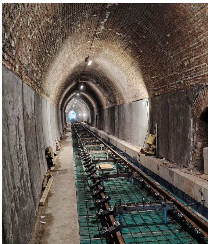
Lavori di rinforzo strutturale e posa della piastra di fondazione metallica all'interno della galleria storica Ramera a binario unico
