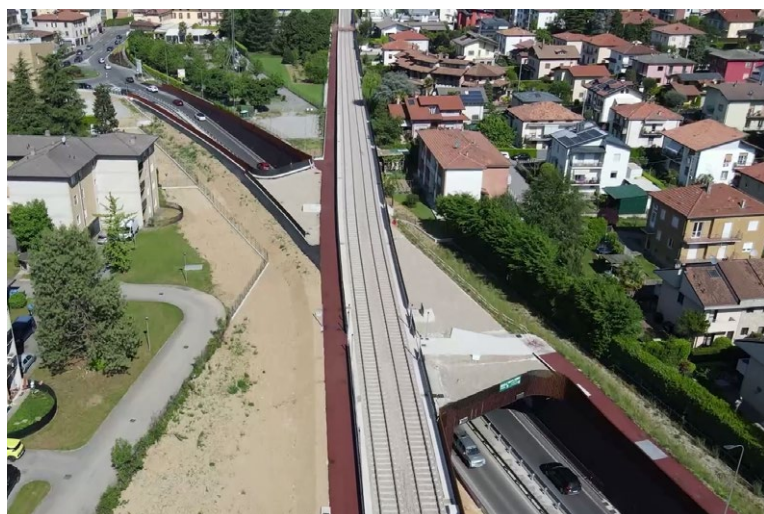
Il nuovo sottopasso della circonvallazione Fabriciano a Bergamo
