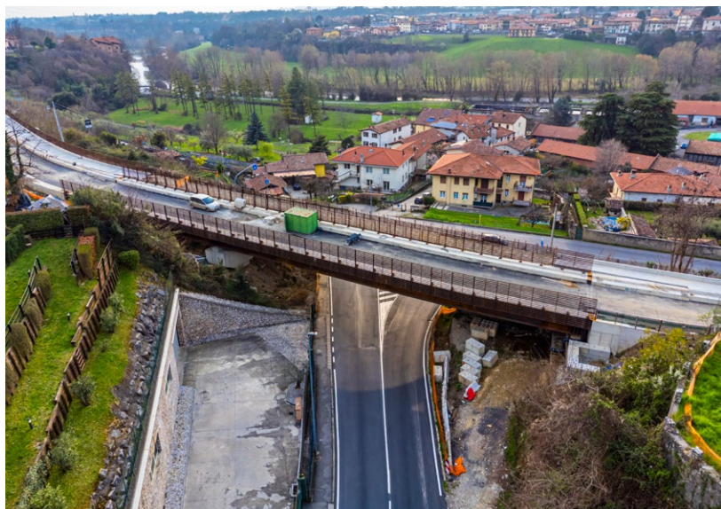
L'imponente struttura del nuovo ponte sul torrente Rino a Villa d'Almè con impalcato misto acciaio-calcestruzzo che scavalca la viabilità sottostante
