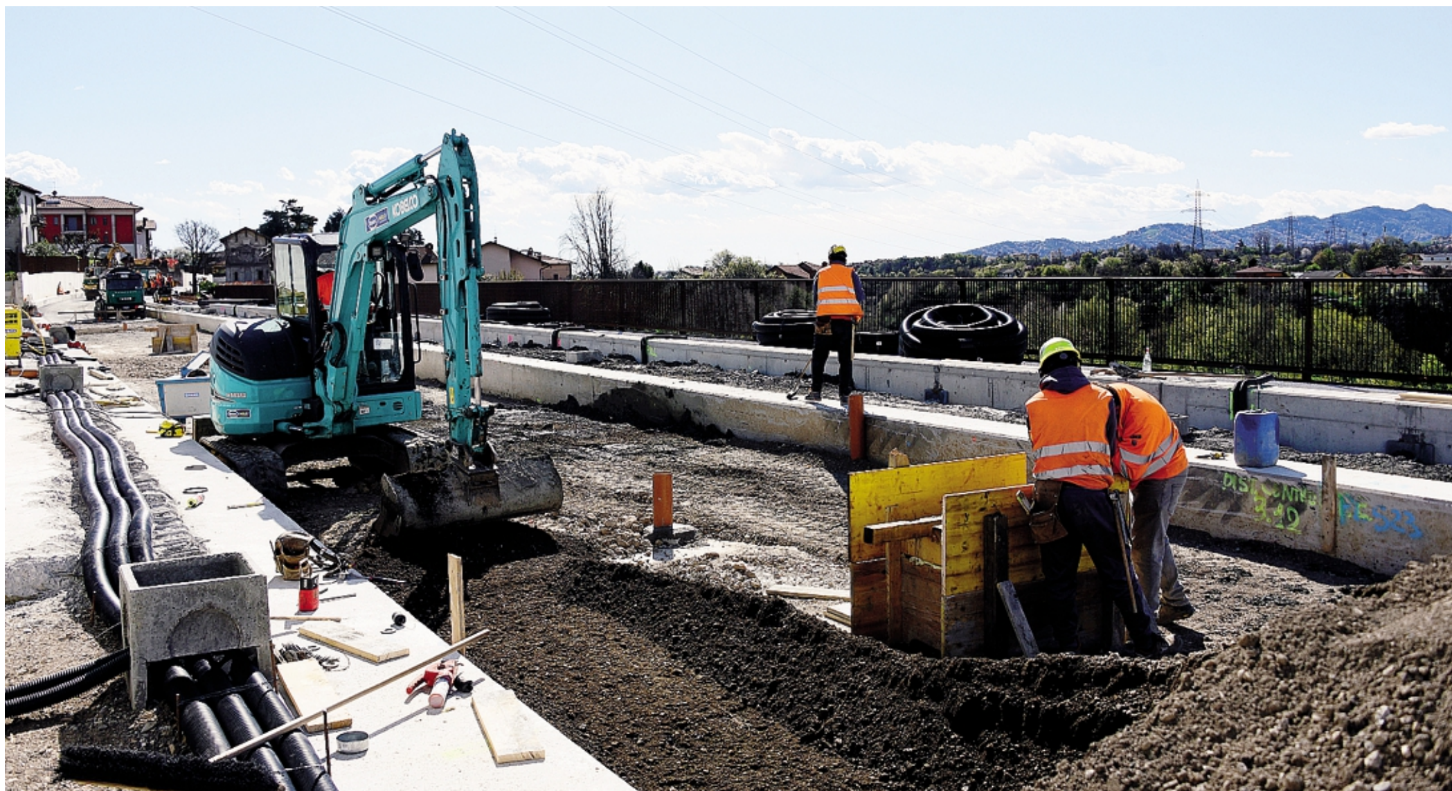
Lavori in corso in prossimità della futura fermata di Villa d'Almè Mazzi FOTO BEDOLIS
