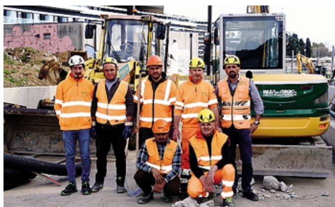
Una squadra al lavoro all'altezza di ChorusLife a Bergamo
