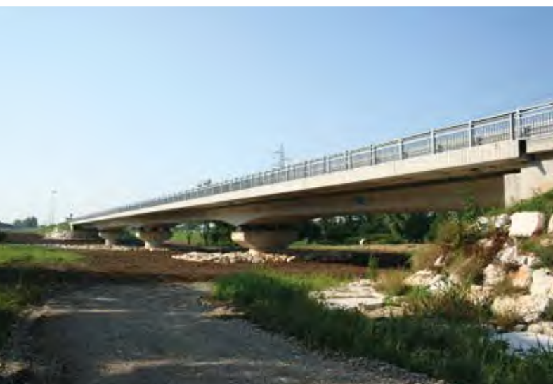
Costruzione della nuova SP 91 di Valle Calepio 2° lotto da Costa Mezzate a Chiuduno
