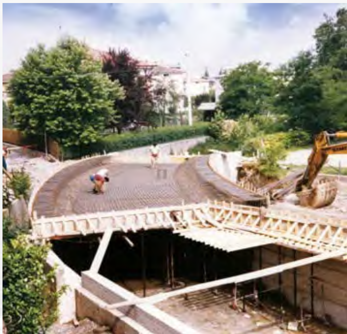
1984 - Albano Sant'Alessandro (BG) - Canalizzazione torrente Zerra
