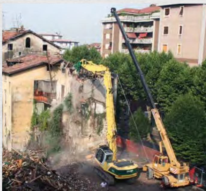
2009 - Bergamo - Demolizioni fabbricati via Broseta
