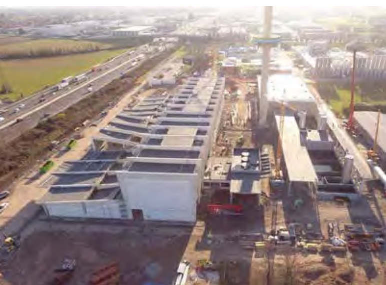
Comune di Filago (BG) BRENNTAG S.p.A Realizzazione nuovo polo industriale produttivo
