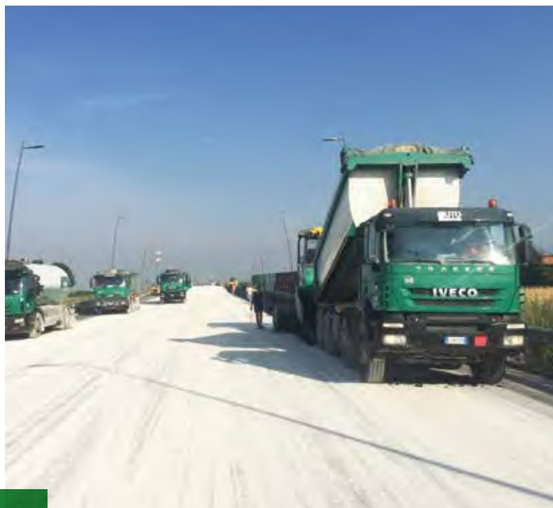
Tangenziale Sud di Bergamo Lotto 1 da Zanica a Stezzano
