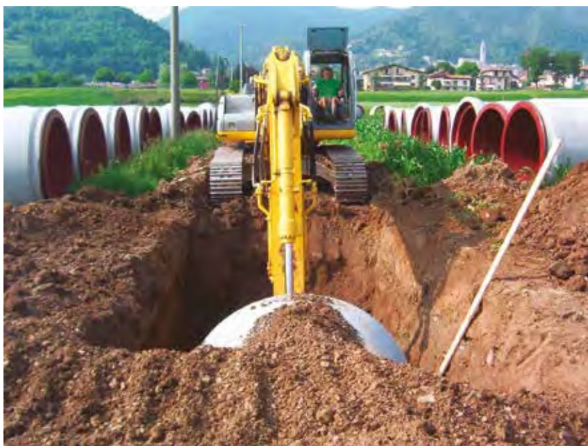
Clusone (BG) - Realizzazione collettamenti e fognature
