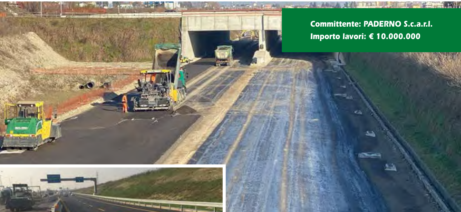
Nuova S.P. 46 - Lotto Rho-Monza Tratti 1 e 2 - Adeguamento Austradale. Esecuzione delle pavimentazioni stradali in conglomerato bituminoso
