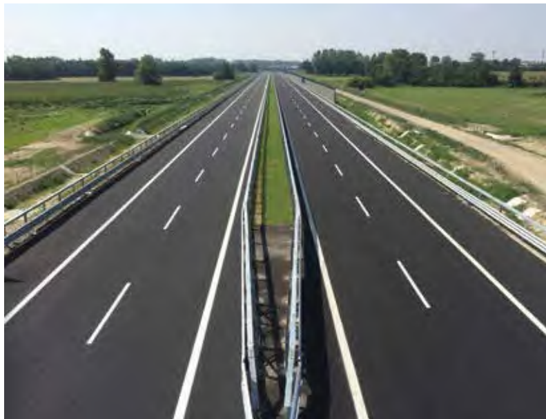
Fondazioni stradali e pavimentazioni in conglomerato bituminoso. SP 14 Rivoltana e Variante di Liscate.
