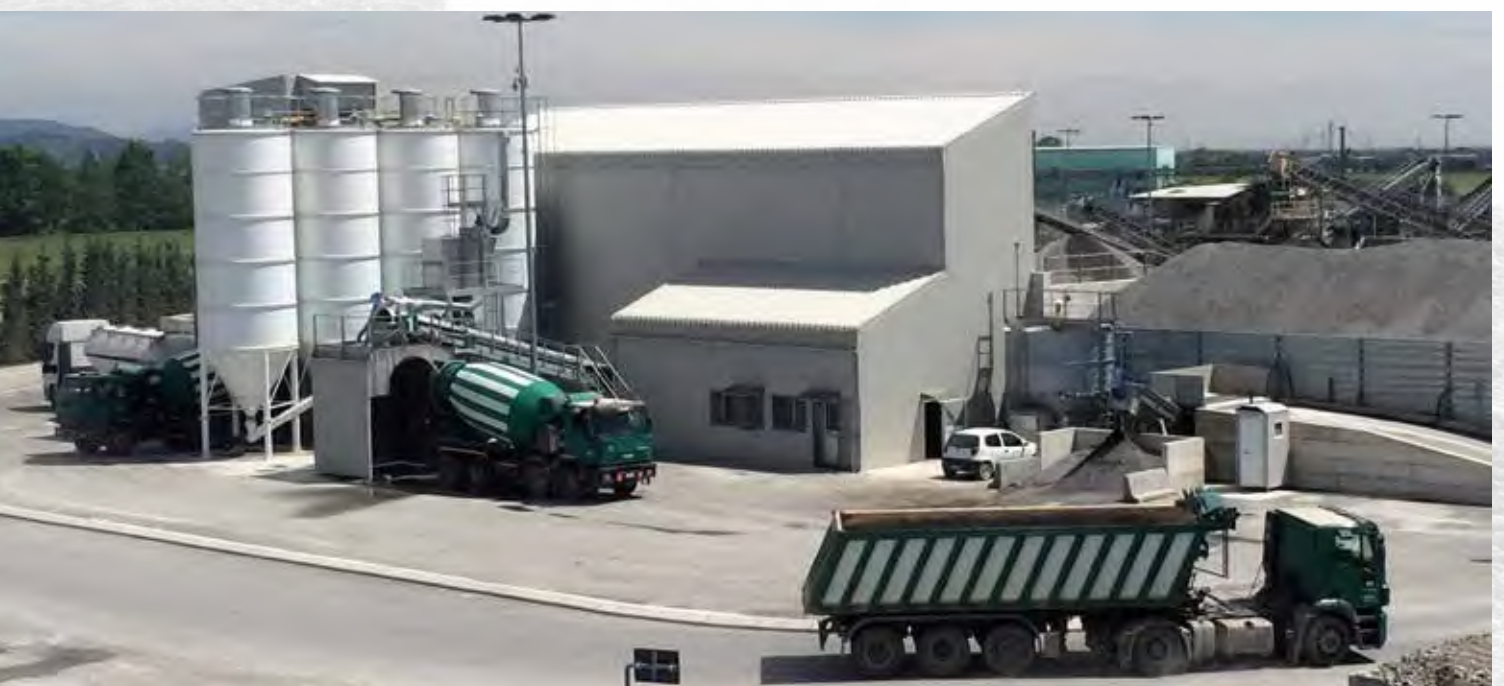
Impianto produzione calcestruzzo
