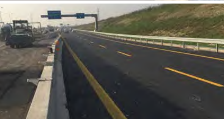
Nuova S.P. 46 - Lotto Rho-Monza Tratti 1 e 2 - Adeguamento Austradale. Esecuzione delle pavimentazioni stradali in conglomerato bituminoso
