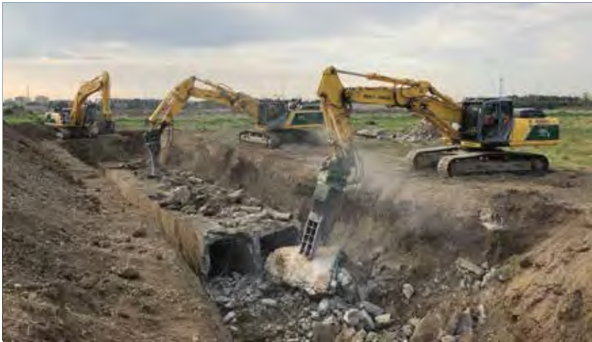
Segrate (MI) - Demolizione nell'ambito del Westfield Milan
