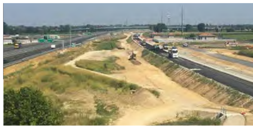
Sub-ballast ferroviario da pk 28+629 a pk68+315 della tratta ferroviaria AV/AC Milano - Verona
