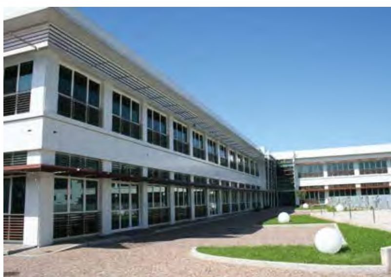
Comune di Seriate (BG) ROSSINI TRADING S.p.A. Realizzazione edifici per attività produttive: sede, uffici, logistica e magazzino robotizzato.
