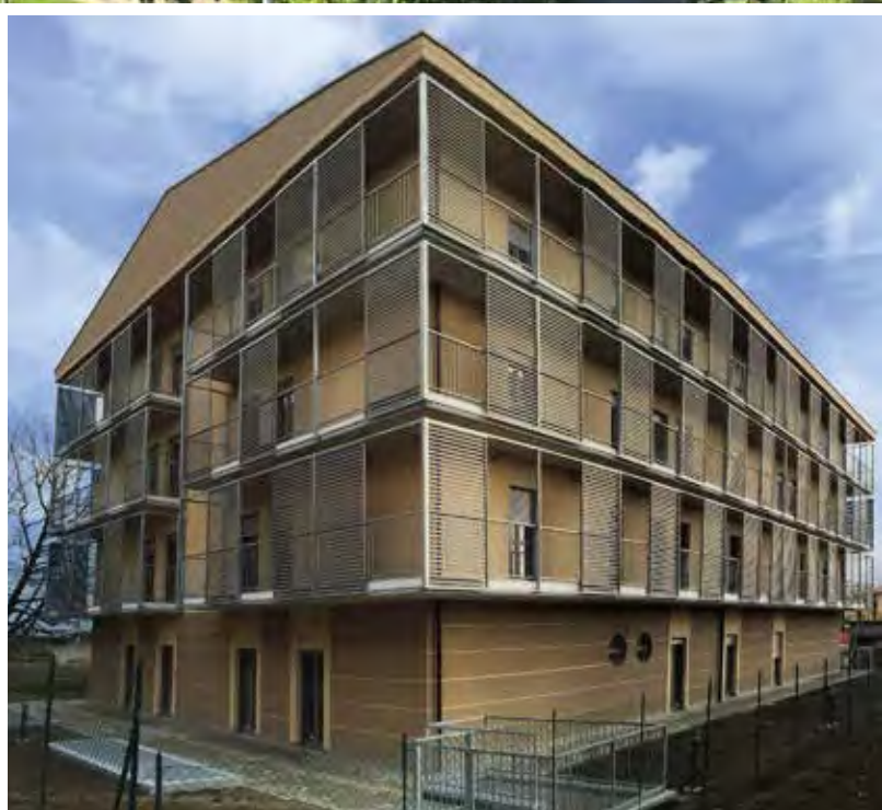
Bergamo (BG) - Nuovo intervento in edilizia sociale Fondazione MIA
