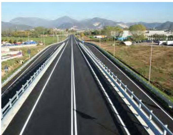
Lavori di costruzione della variante alla SS n. 42 del Tonale e della Mendola
