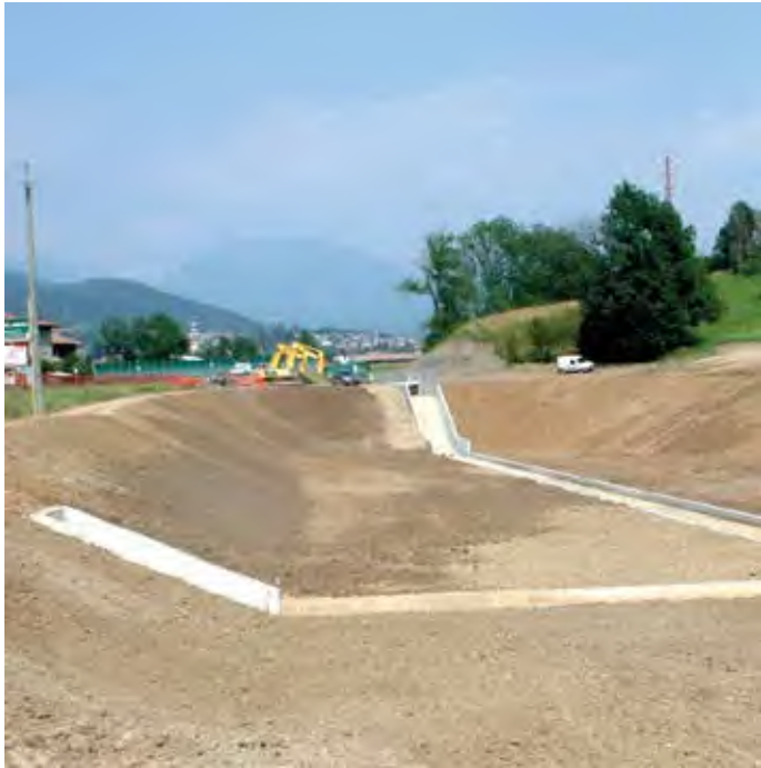
CLUSONE (BG) Realizzazione collettamenti e fognature
