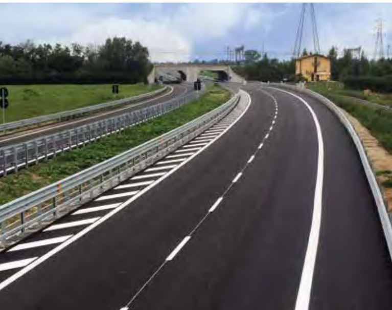
Fondazioni stradali e pavimentazioni in conglomerato bituminoso Lotto OI - Treviglio (BG)
