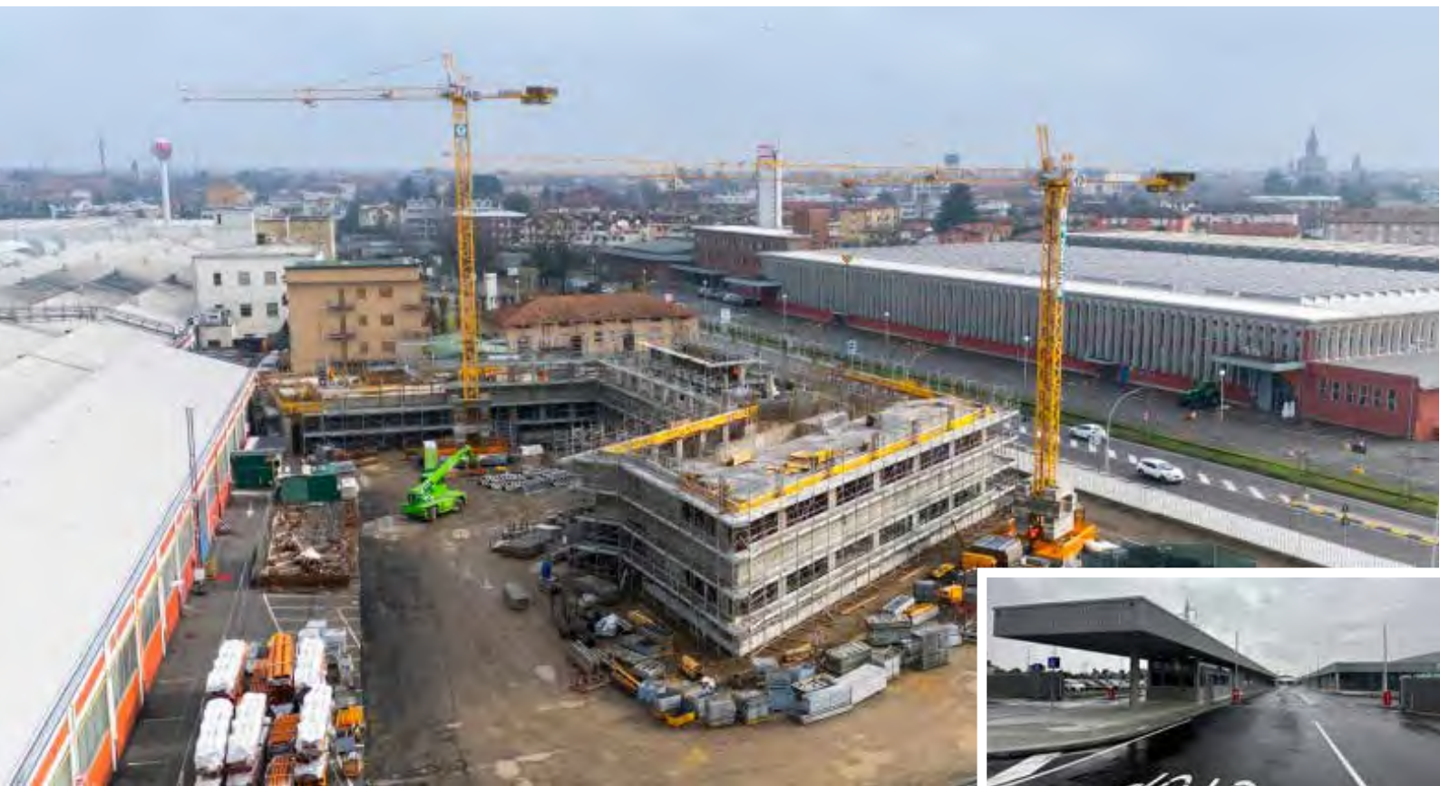
Riqualificazione del Campus e costruzione di una nuova palazzina uffici nel comune di Treviglio (BG)
