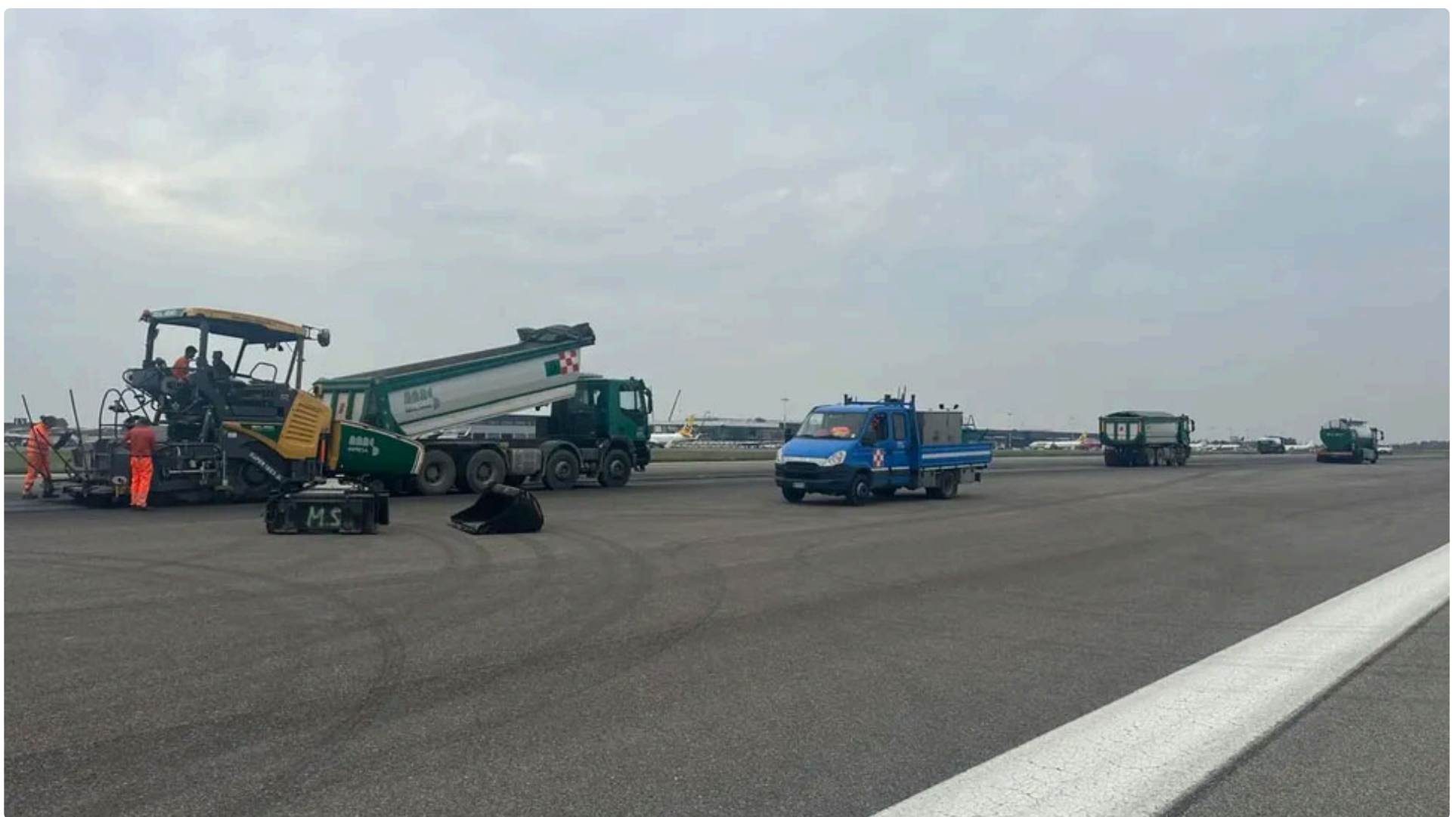
I mezzi dell'Impresa Milesi durante i lavori di ripristino della pista
