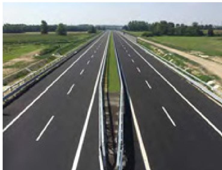
Esecuzione di misto cementato in sito, stabilizzazione materiale in rilevato, fornitura e stesa di conglomerati bituminosi (base, binder, drenante e cordolature) per la realizzazione del pacchetto di fondazione stradale della S.P.14 Rivoltana e della variante di Liscate.
