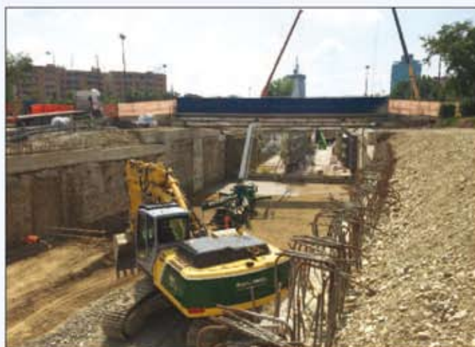
12. Le fasi di scavo e di costruzione della galleria
