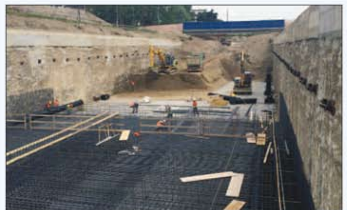
11. La fase di costruzione della galleria artificiale: il solettone di fondo e le paratie tirantate
