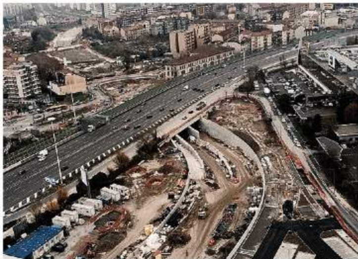
Il maxi cantiere della Zara-Expo, con la galleria sotto l'autostrada A4, visto dal 22° piano dell'hotel Barceló
