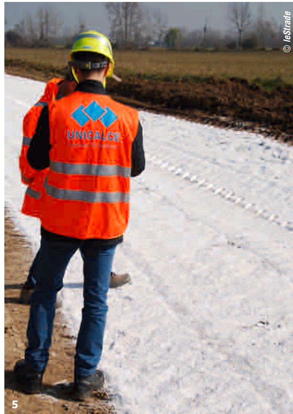
3, 4. Spandicalce in azione e strada trattata a calce
