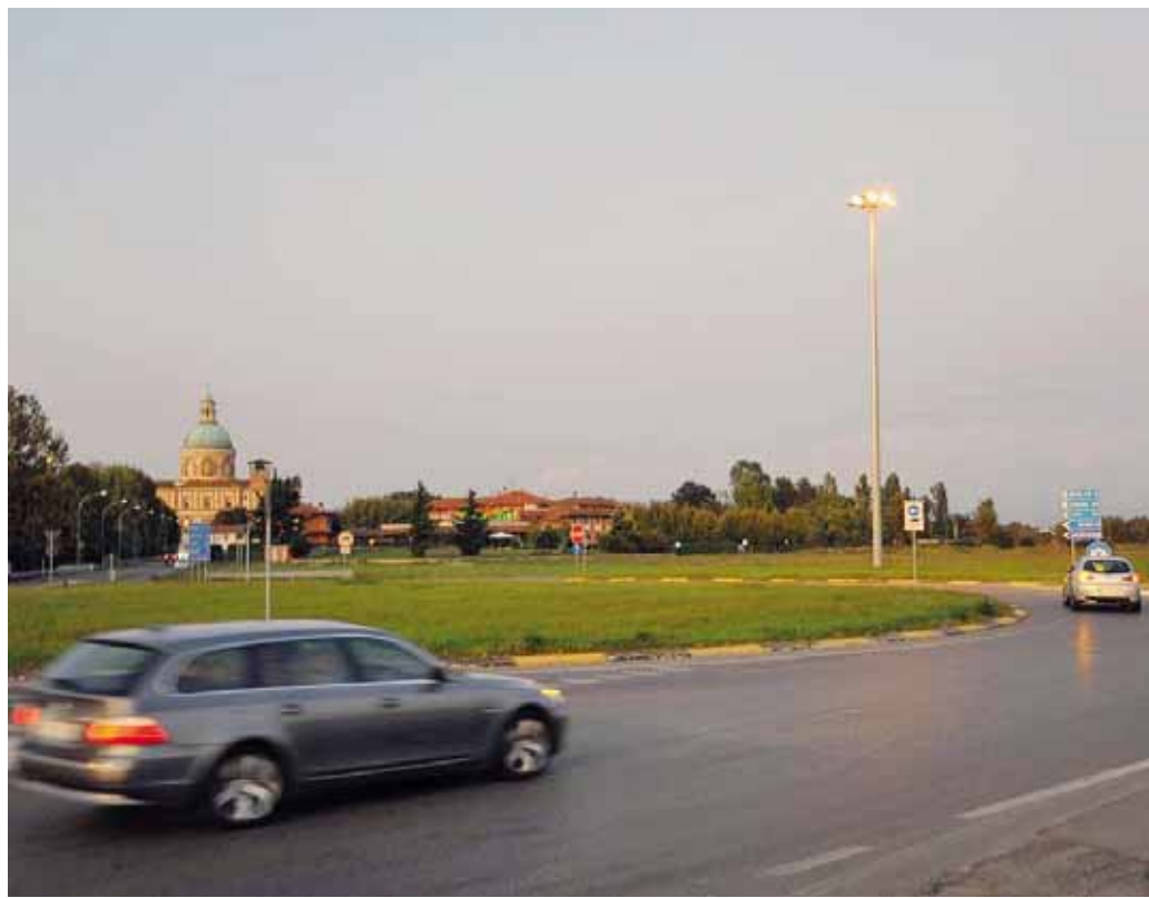
Aggiudicati ieri i lavori per la tangenziale Ovest di Caravaggio, che collegherà la Rivoltana al futuro casello Brebemi
