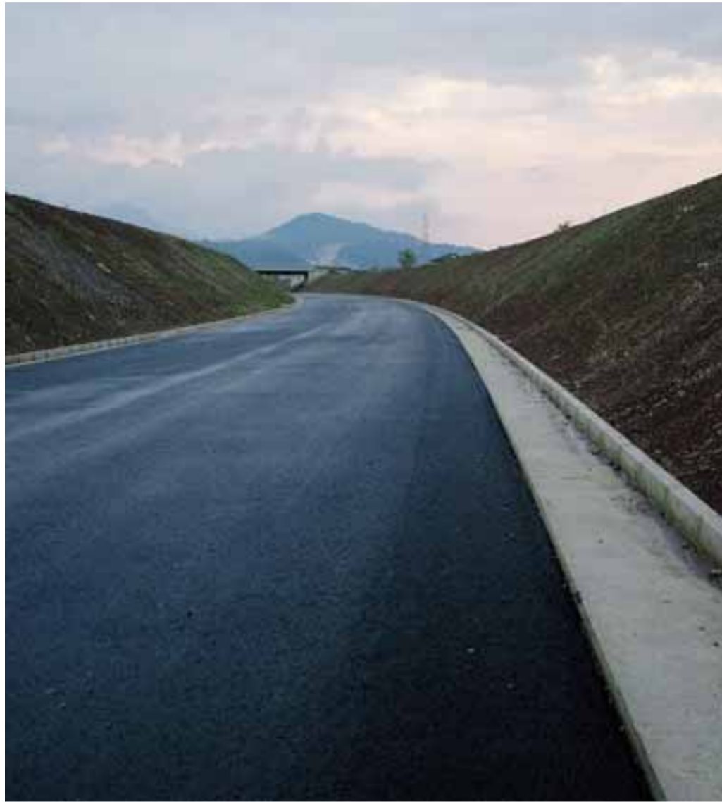
Lo svincolo di San Paolo d'Argon ormai ultimato della nuova variante alla strada statale 42 FOTO BERG
