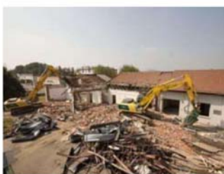
Ex Indesit, via alla demolizione (Foto by Colleoni Foto)
