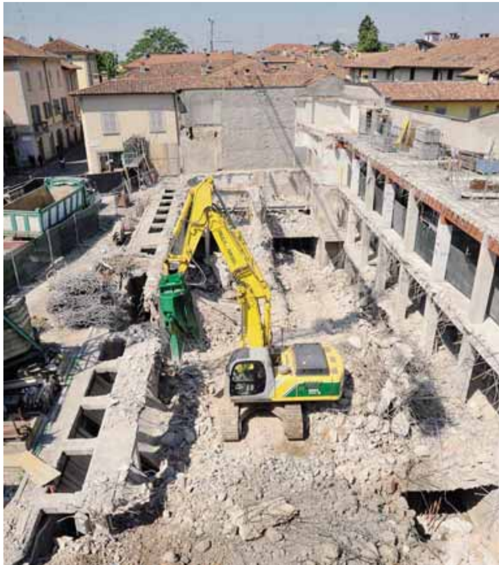
Il cantiere dell'ex Upim. Si lavora per realizzare l'auditorium FOTO CESNI
