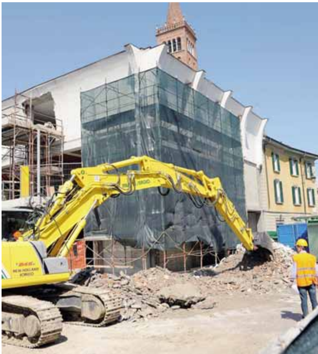
Il cantiere dell'ex Upim a Treviglio: sono iniziati gli scavi per l'auditorium FOTO CESNI
