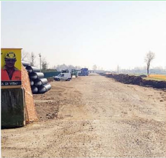
Il cantiere del primo lotto della tangenziale Est a Verdello
