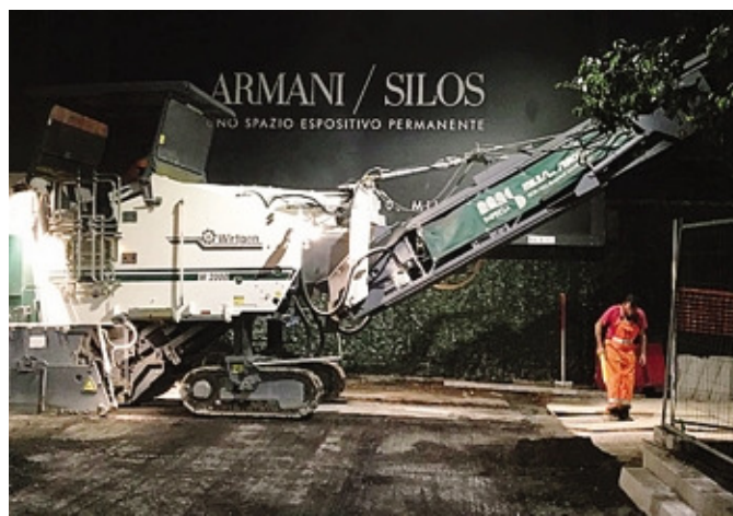
Lavori nel complesso Armani, nel quadrilatero della moda milanese
