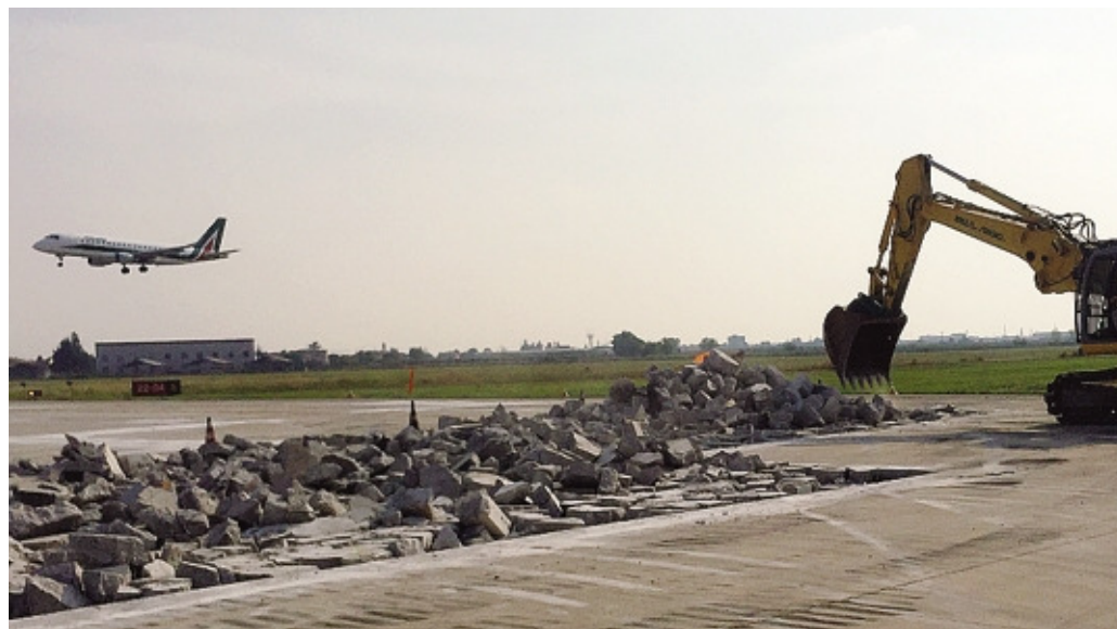
I lavori della Milesi di Gorlago all'aeroporto veronese Catullo: in programma la riqualificazione delle piste
