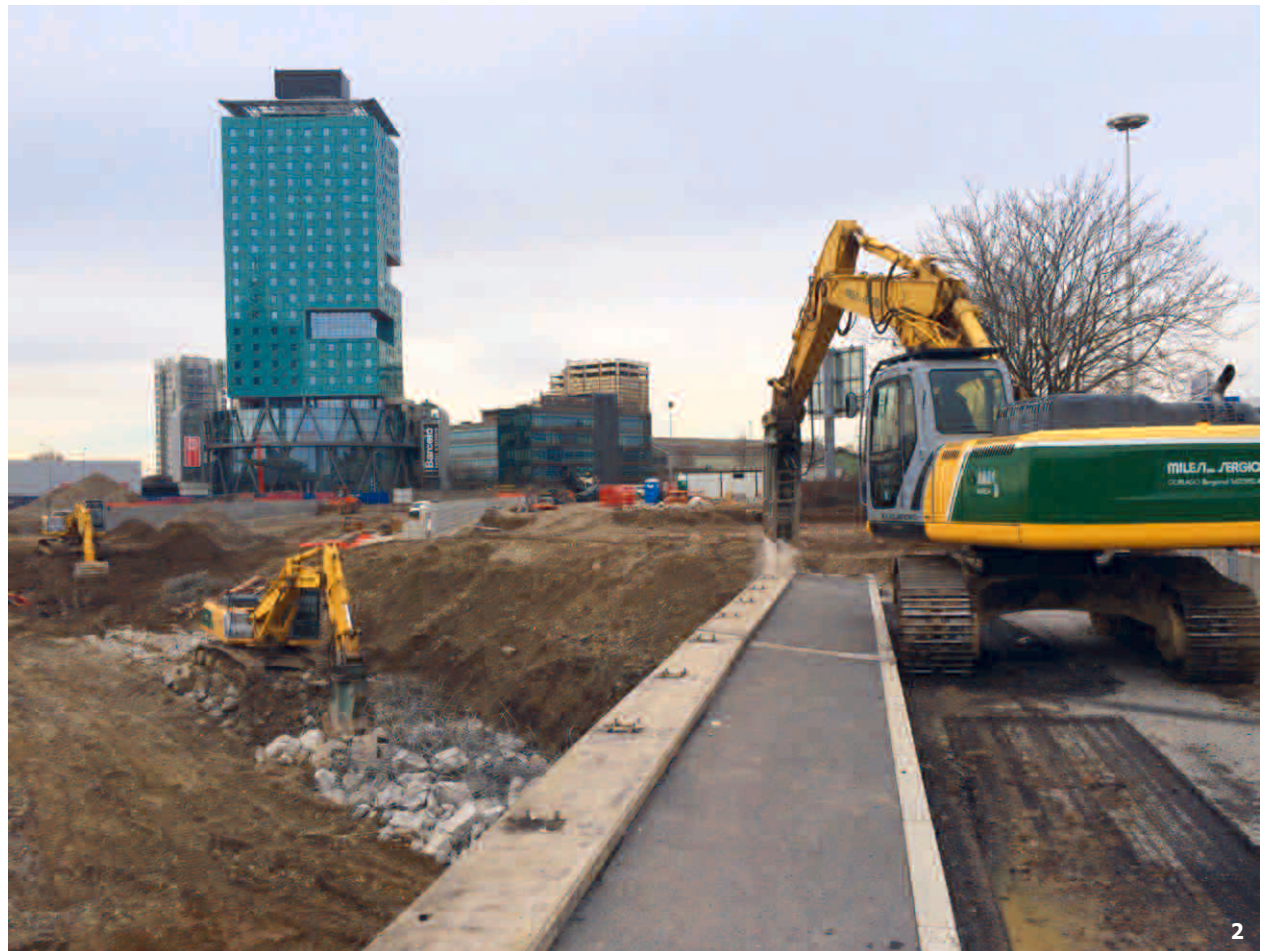
1. Veduta aerea del cantiere milanese in esecuzione
